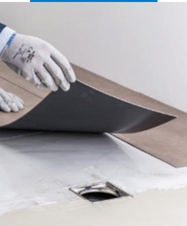
Posa di LVT con Ultrabond Eco MS 4 LVT in ambiente umido
